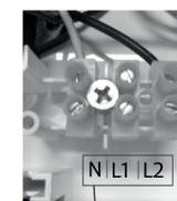
Identificação no corpo do produto, indicando as vias do borne. Ligue os fios da rede, neste lado do borne, conforme a velocidade desejada.
